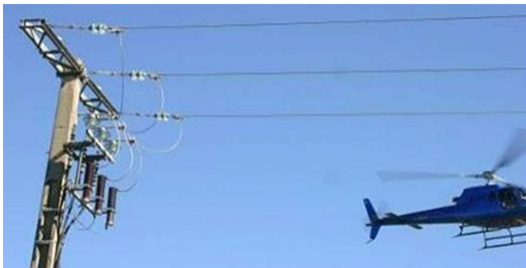
Visite du réseau aérien par hélicoptère
