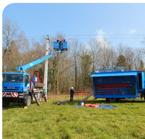
Travaux de maintenance HTA réalisés sous tension
